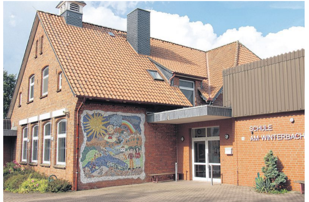
Die Winterbachschule wird jetzt zur Hälfte als Grundschule genutzt. Die andere Hälfte steht der Gemeinde zur Verfügung.
